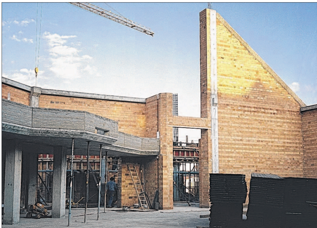
Rohbau der Kirche „Christus unser Leben“ in Thalfingen.
